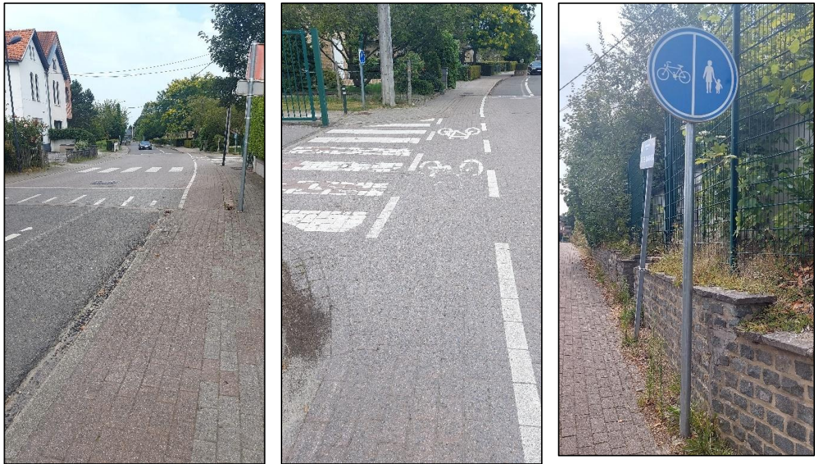
Photo 10 : Trottoir cyclopiéton et sa traversée en plateau rue des Volontaires (Agora)
