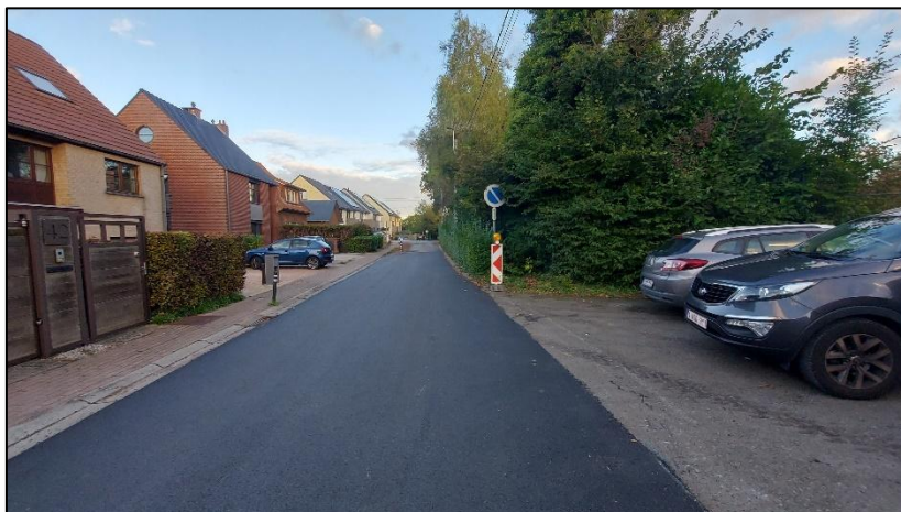
Photo 12 : Ré asphaltage rue du Tilleul (Agora)
