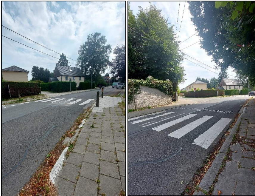
Photo 6 : Trottoirs rue de la Bruyère (Agora)
