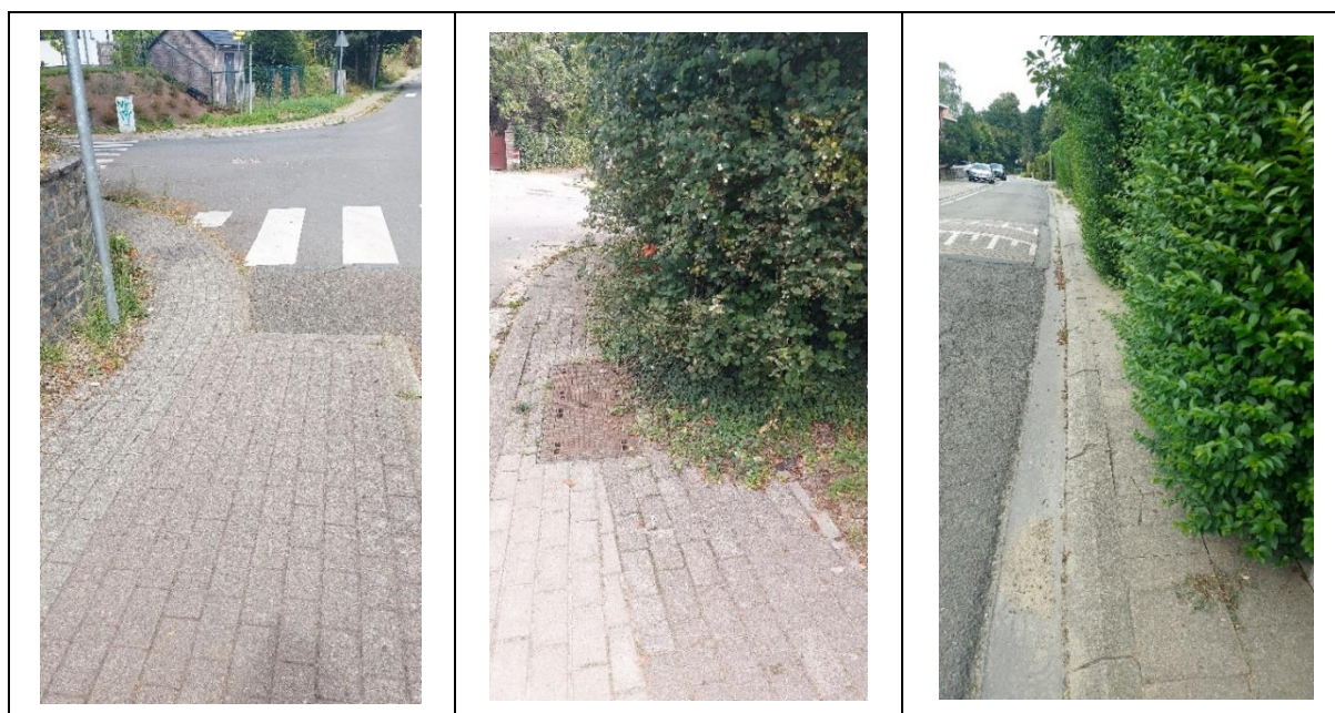
Photo 3 : État des trottoirs existants rue du Tilleul (Agora)
