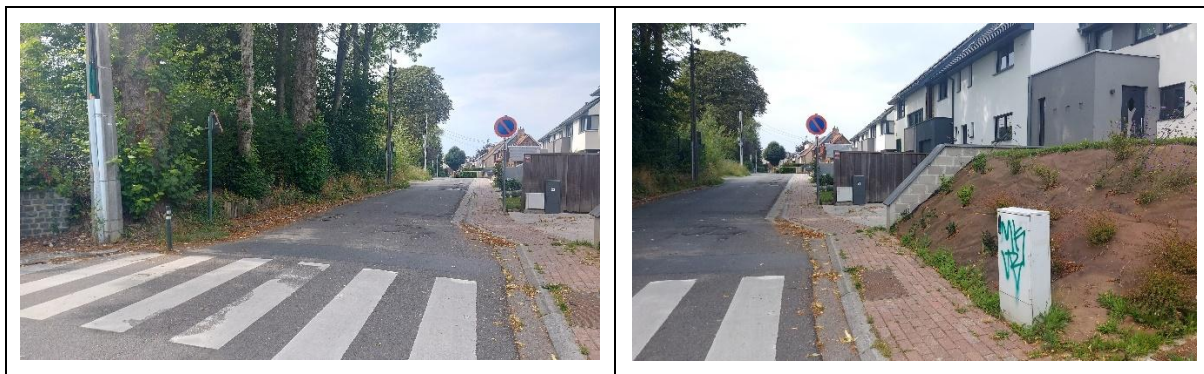
Photo 4 : État des trottoirs existants et récents – rue du Tilleul (Agora)
