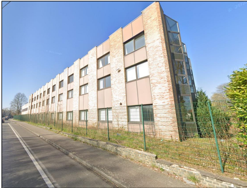
Photo 2 : Anc. bâtiment de GSK maintenu sur le site
