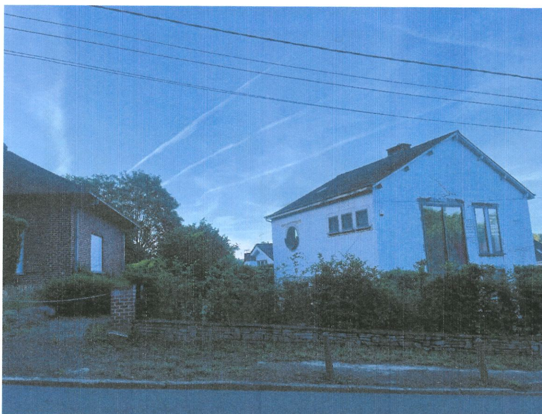
Façade Nord - Est
