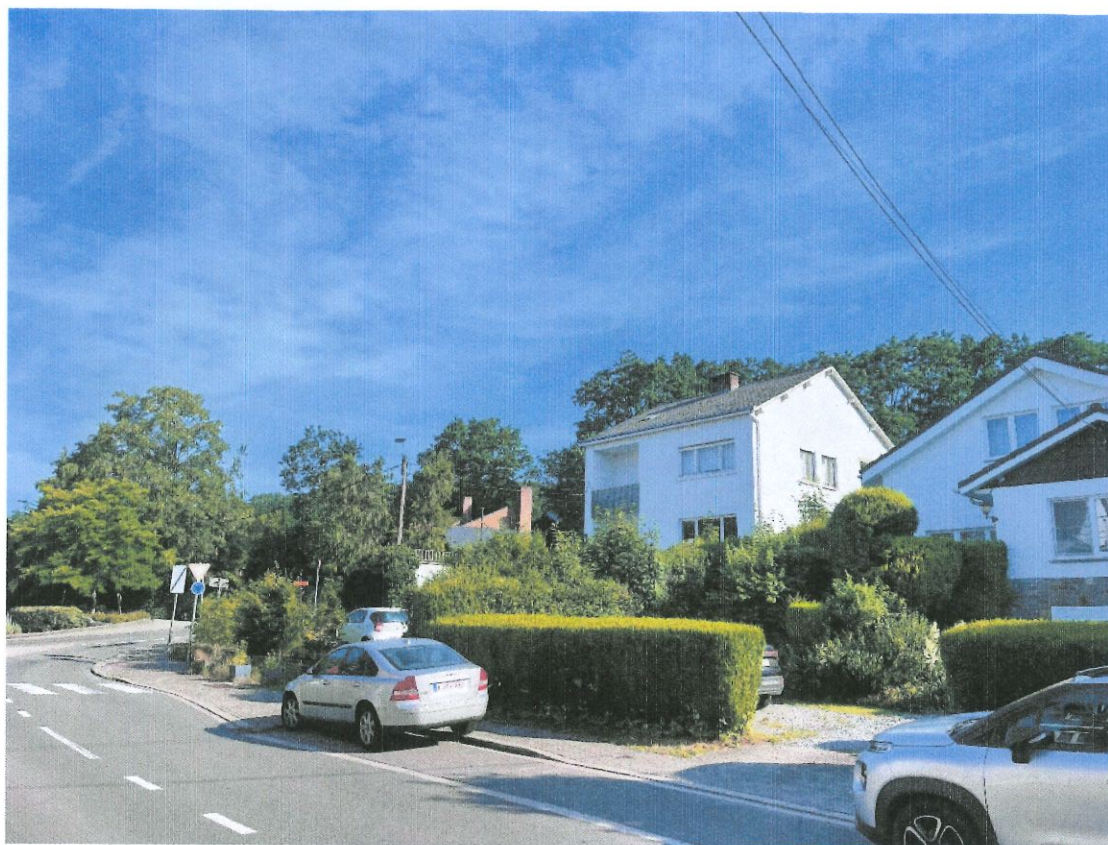
Façade Sud - Est
