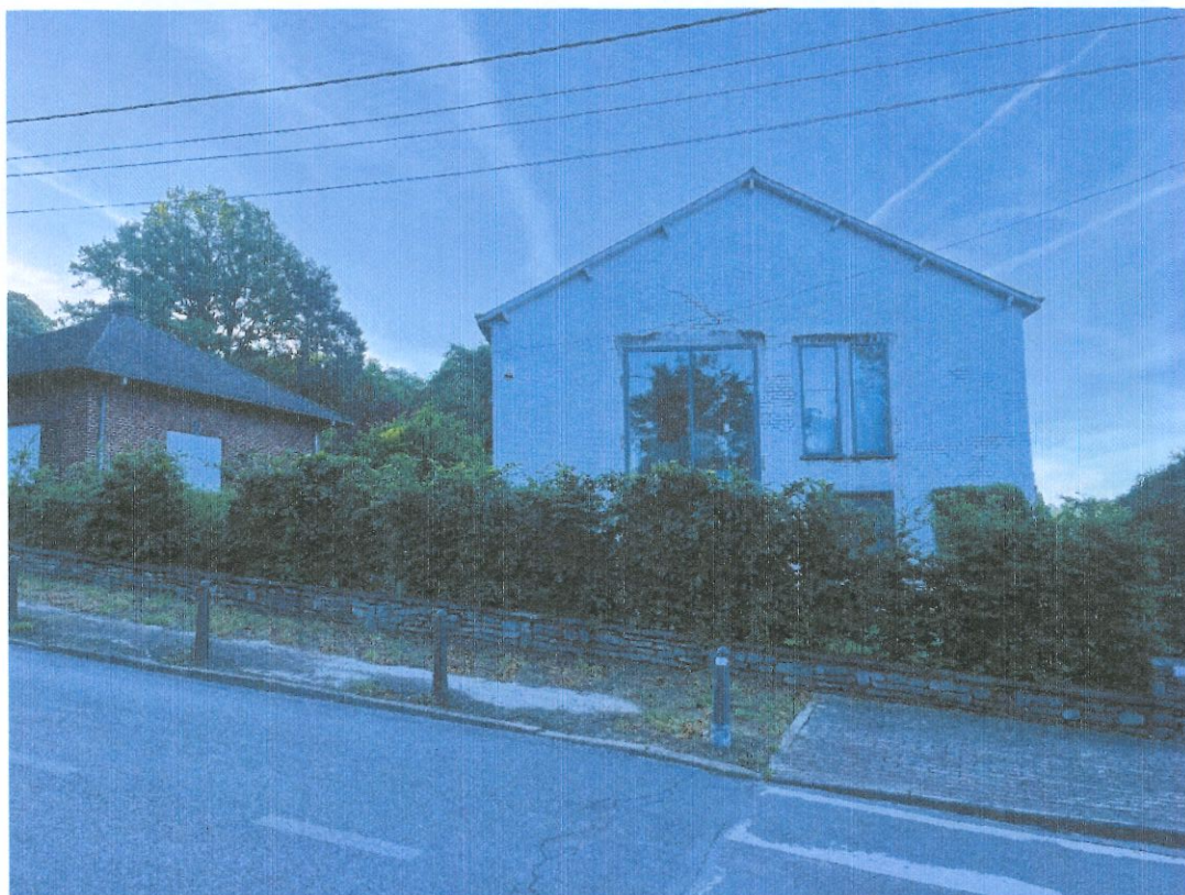
Façade Nord – Ouest sise Rue de Genval 59 à 1331 Rosières
