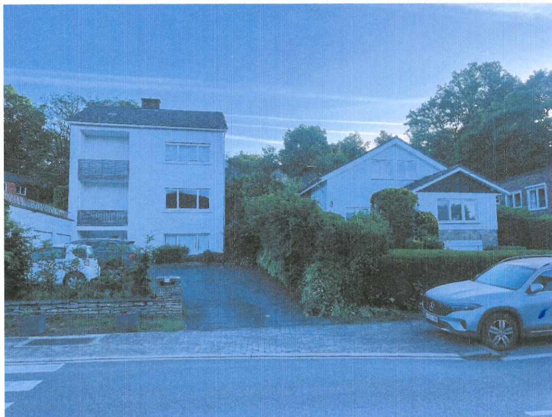
Façade Sud – Ouest sise Rue de La Hulpe 162 à 1331 Rosières
