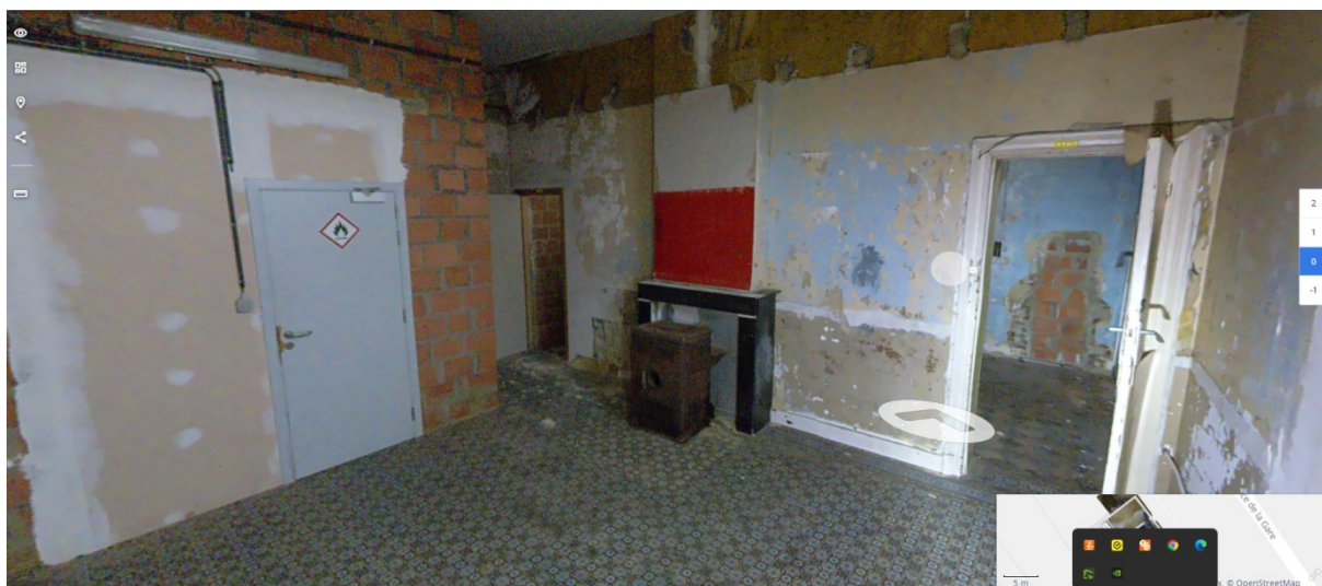
20. Vue intérieure, rez-de-chaussée : salle 04 (situation existante)
