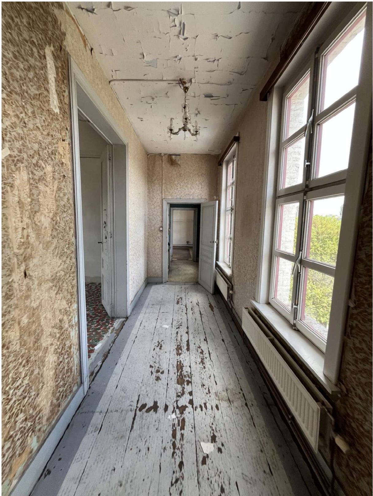
24. Vue intérieure, 1er étage : hall 02
