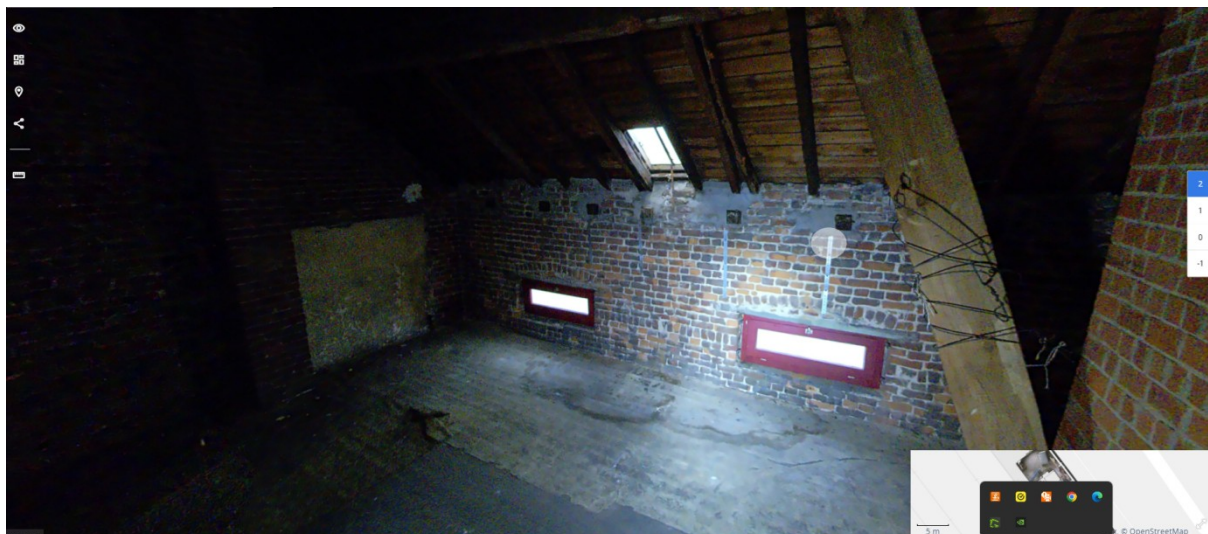
31. Vue intérieure, 2e étage : salle 11
