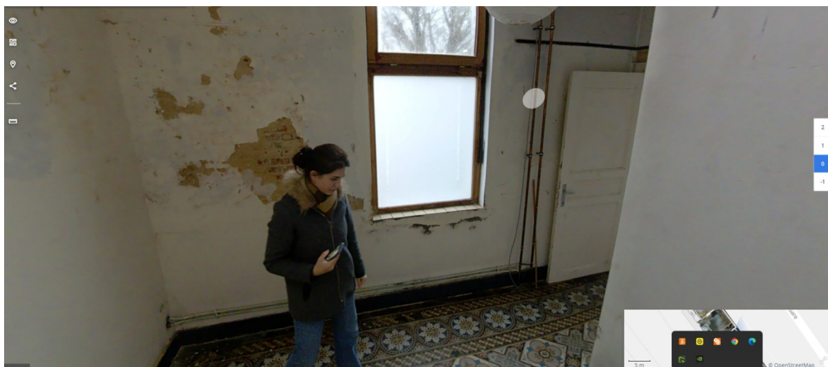
18. Vue intérieure, rez-de-chaussée : salle 02 (situation existante)
