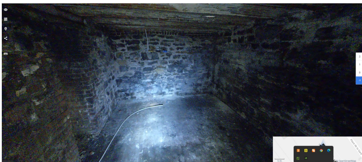
9. Vue intérieure, sous-sol : cave 01
