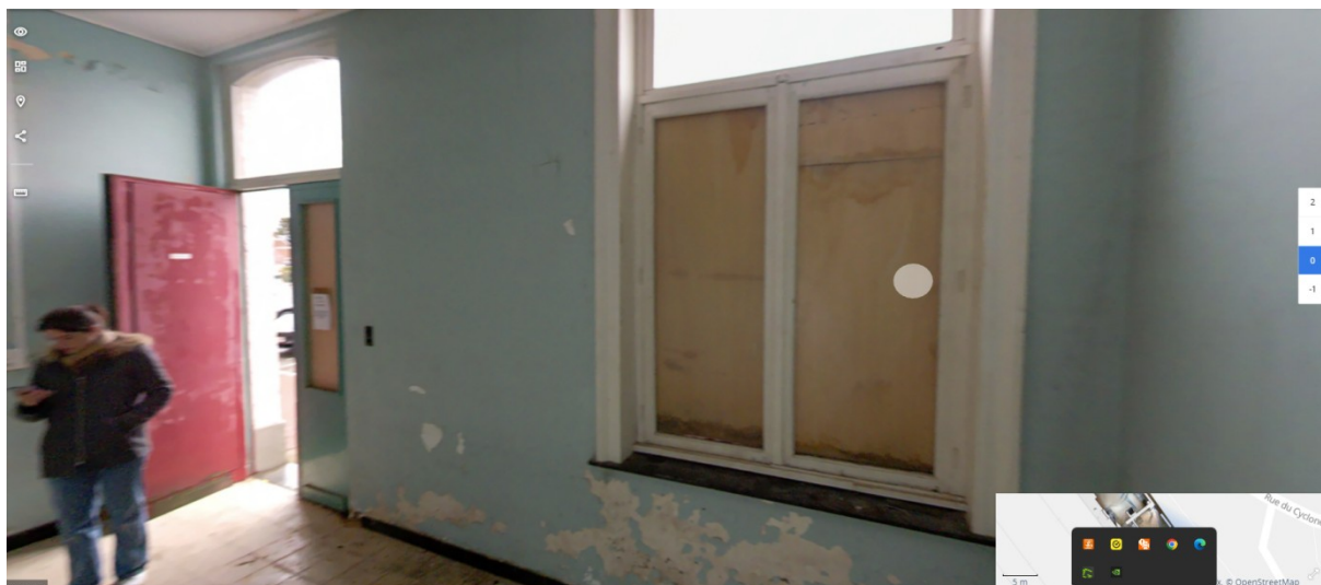
13. Vue intérieure, rez-de-chaussée : salle 00
