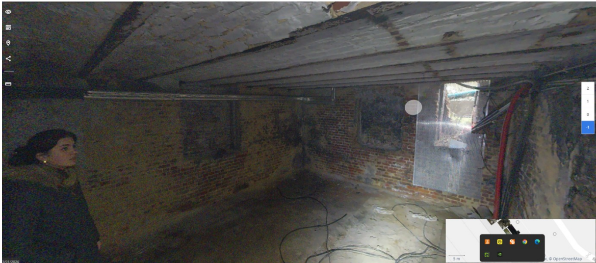
12. Vue intérieure, sous-sol : cave 05
