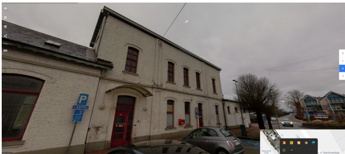
3. Vue extérieure : façade avant (côté droite)
