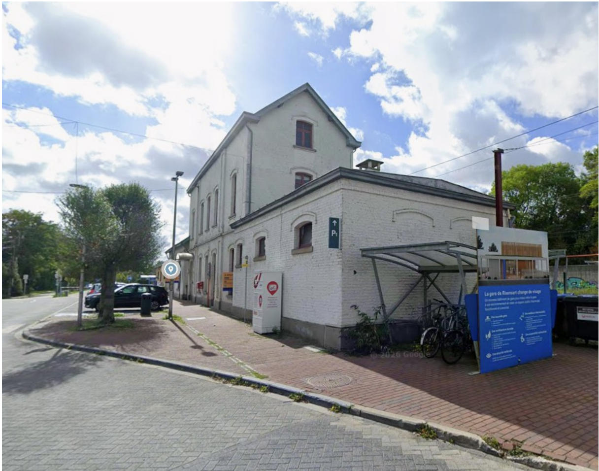
4. Vue extérieure : 3/4 façades avant et latérale droite
