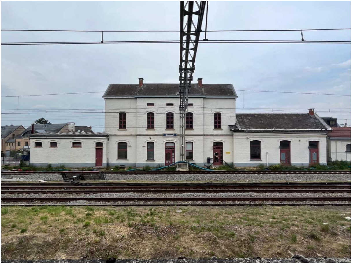
5. Vue extérieure : façade arrière
