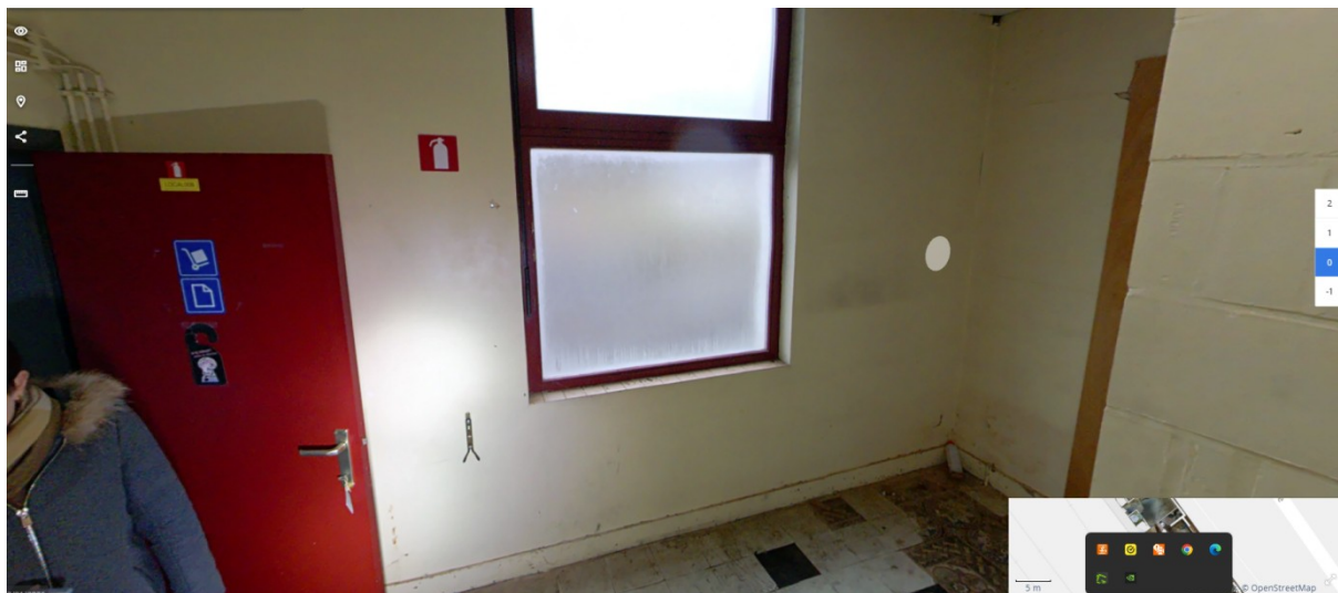
19. Vue intérieure, rez-de-chaussée : salle 03 (situation existante)
