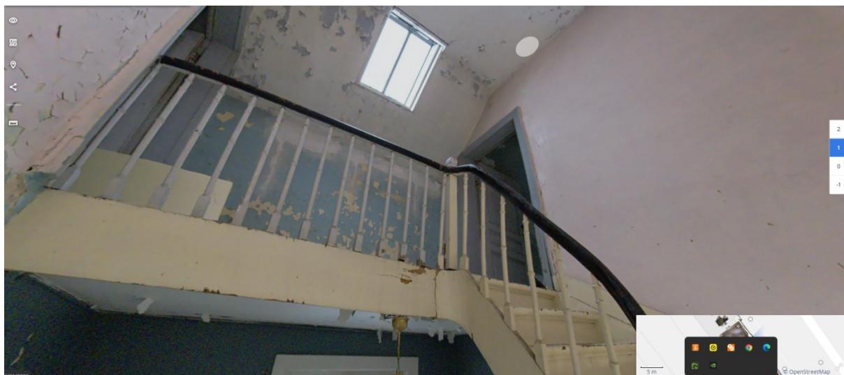
22. Vue intérieure, 1er étage : hall 01 (1/2)
