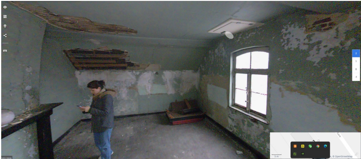
33. Vue intérieure, 2e étage : salle 13
