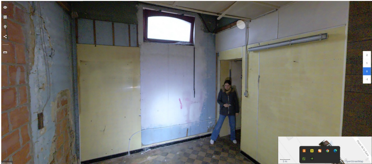
21. Vue intérieure, rez-de-chaussée : salle 05 (situation existante)
