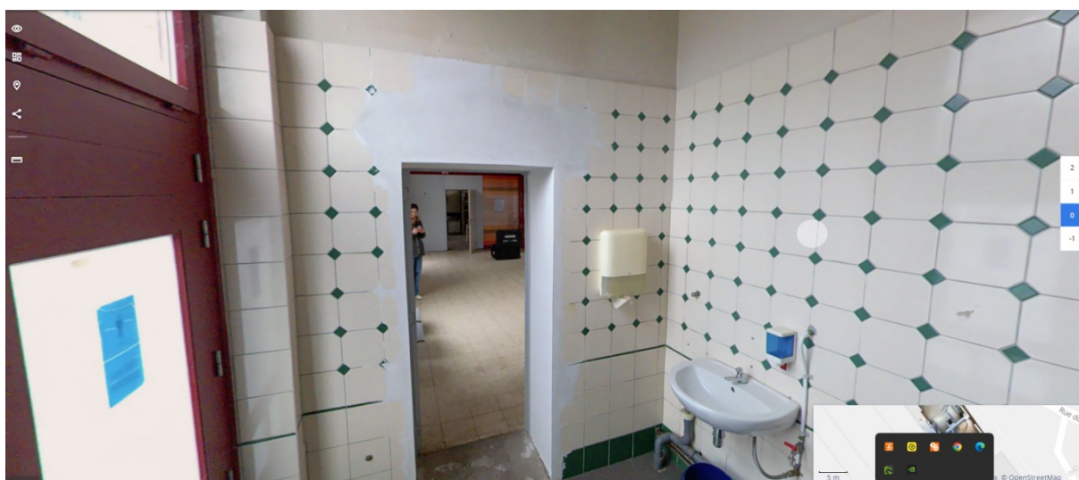
14. Vue intérieure, rez-de-chaussée : sanitaire (situation existante)
