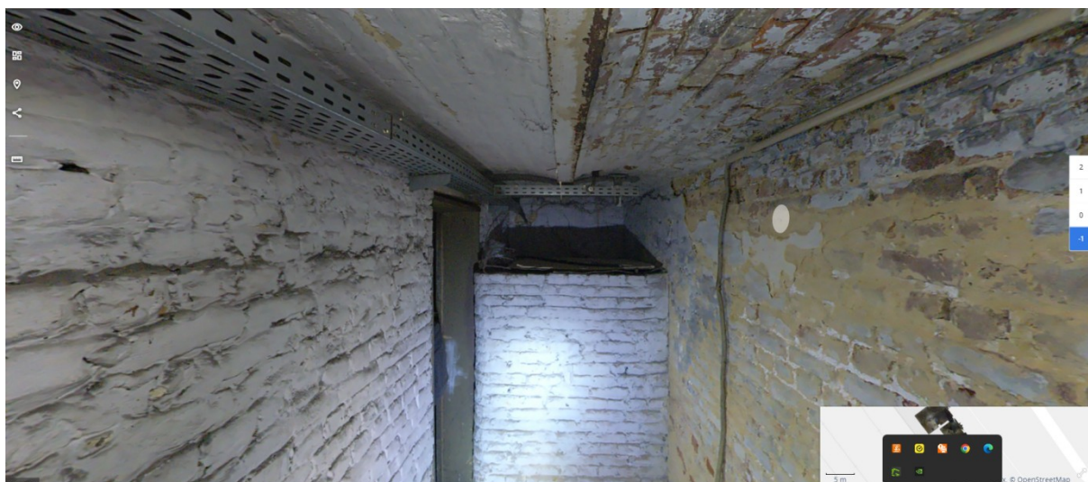
11. Vue intérieure, sous-sol : cave 04
