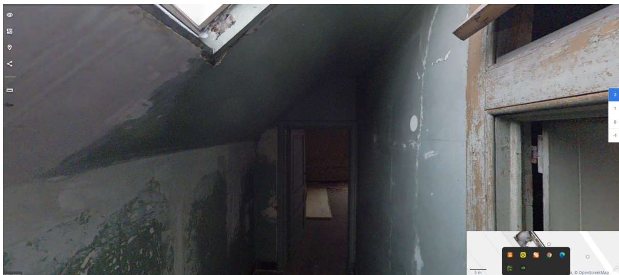
29. Vue intérieure, 2e étage : hall 04
