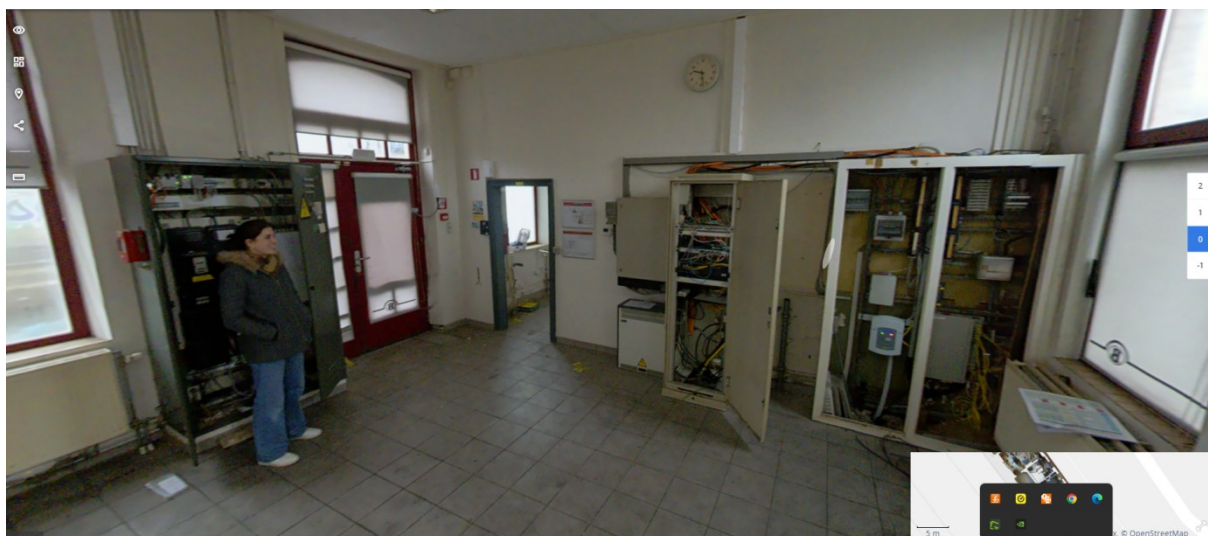
16. Vue intérieure, rez-de-chaussée : salle 01 (situation existante)
