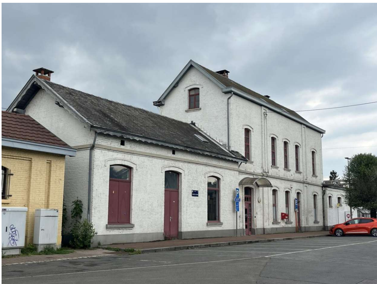
1. Vue extérieure : 3/4 façades avant et latérale gauche
