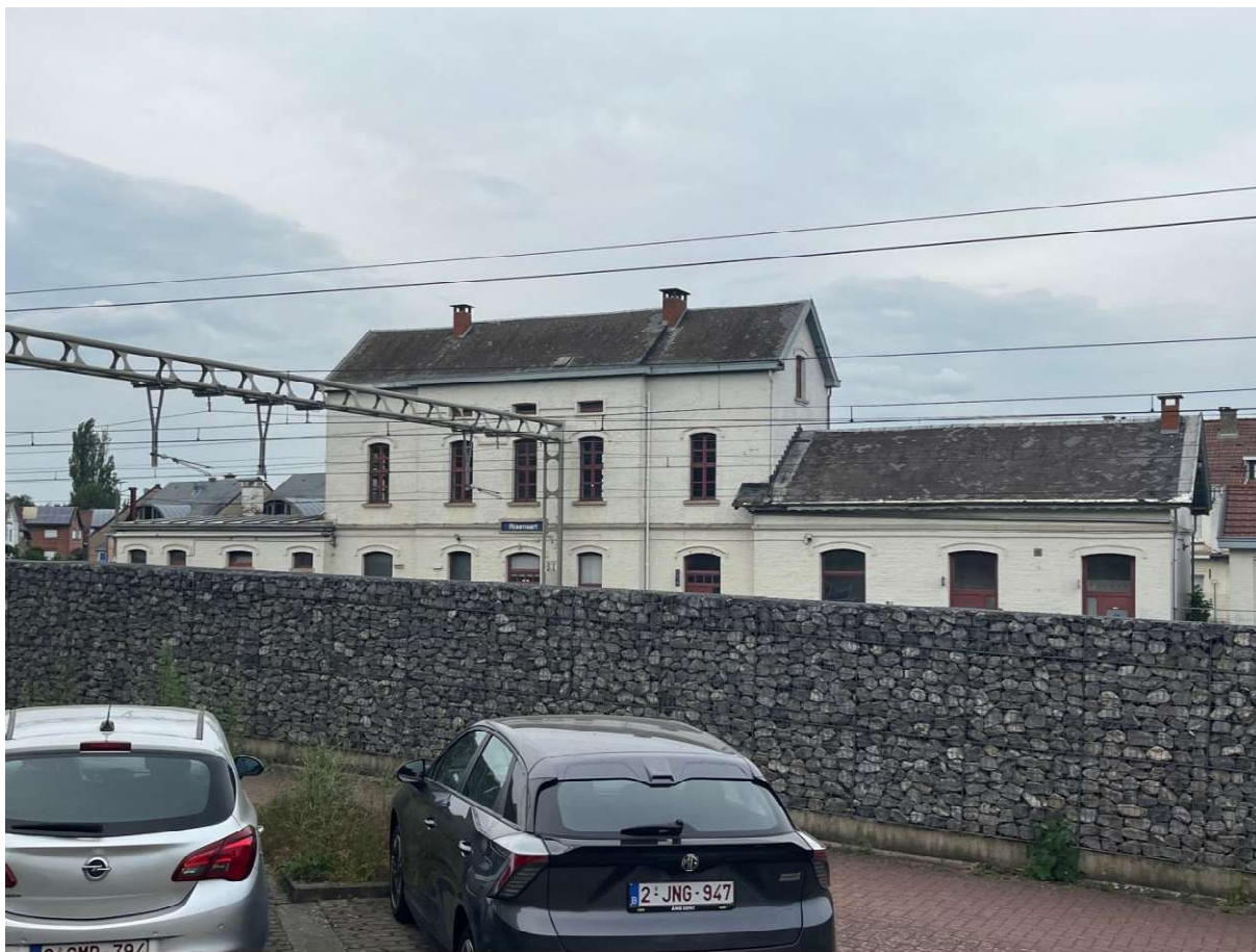
7. Vue extérieure : 3/4 façade arrière et latérale gauche
