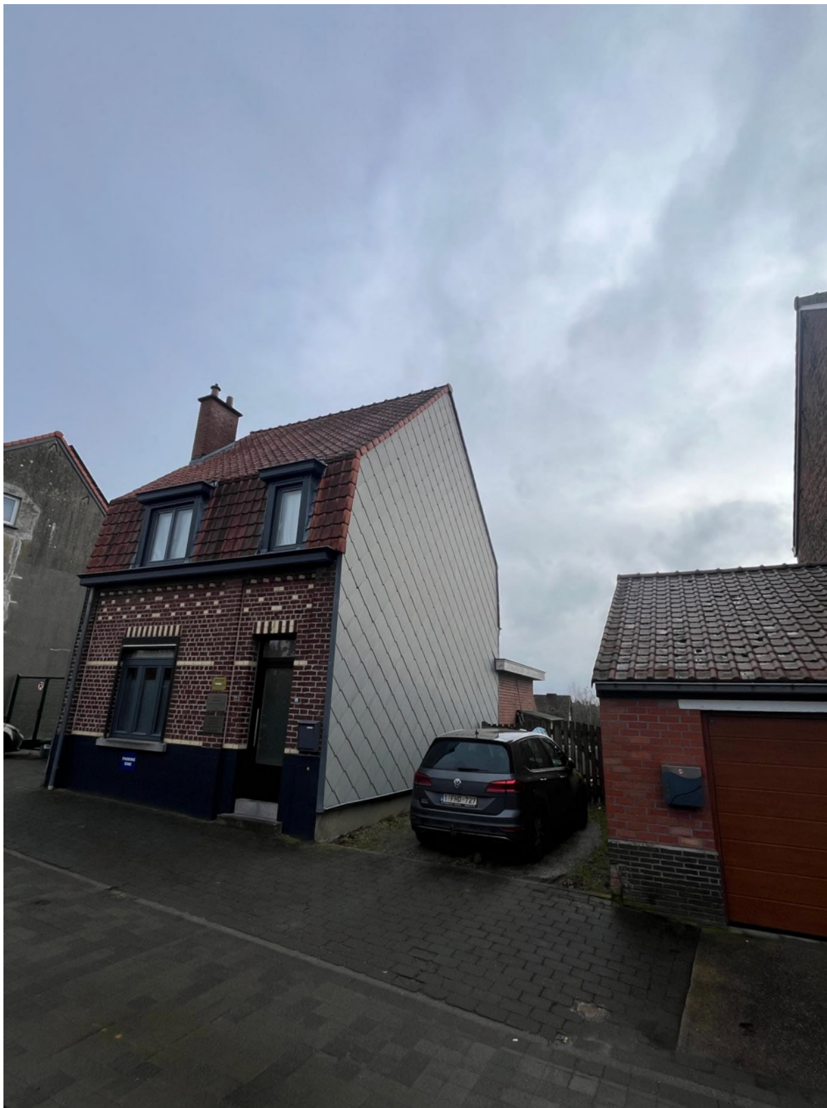
2. Vue 3/4 façade avant, façade latérale droite 2
