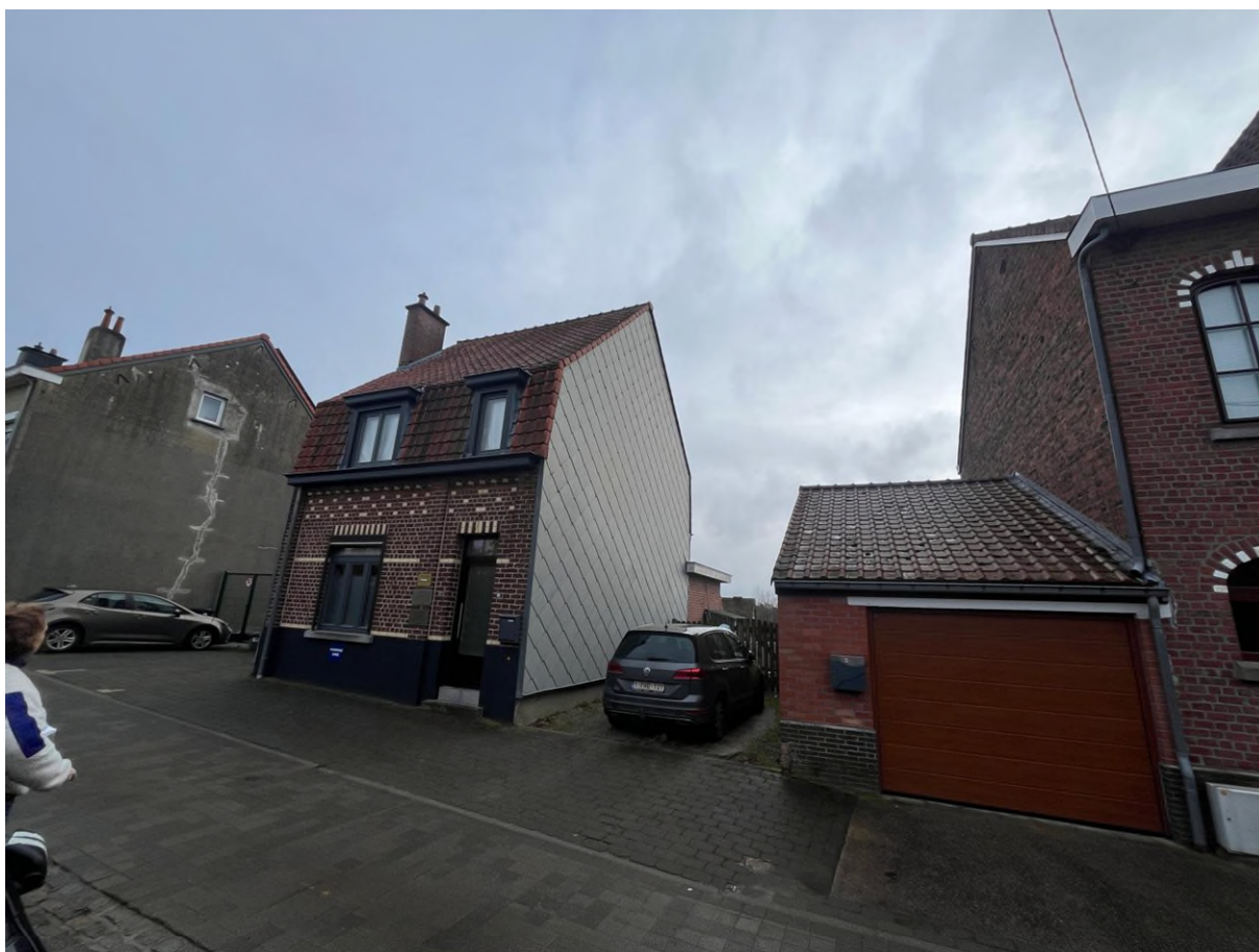
1. Vue 3/4 façade avant, façade latérale droite 1
