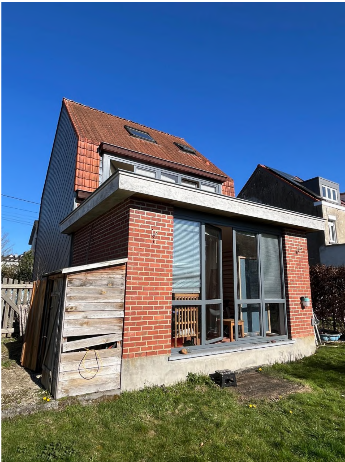
6. Vue 3/4 façade arrière, façade latérale droite 1
