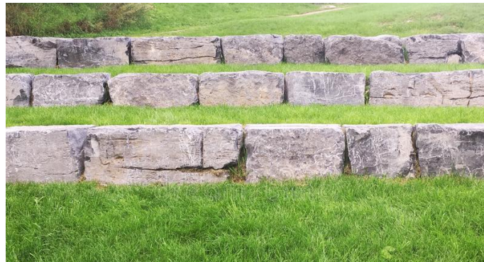
- Exemple d'enrochement utilisé pour la réalisation de gradins -
