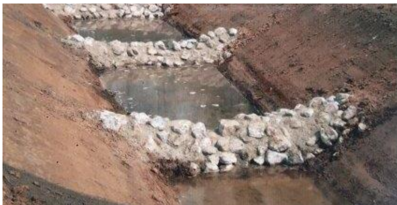
-Exemple de dispositif rocheux de contrôle du flux et de l'érosion-
