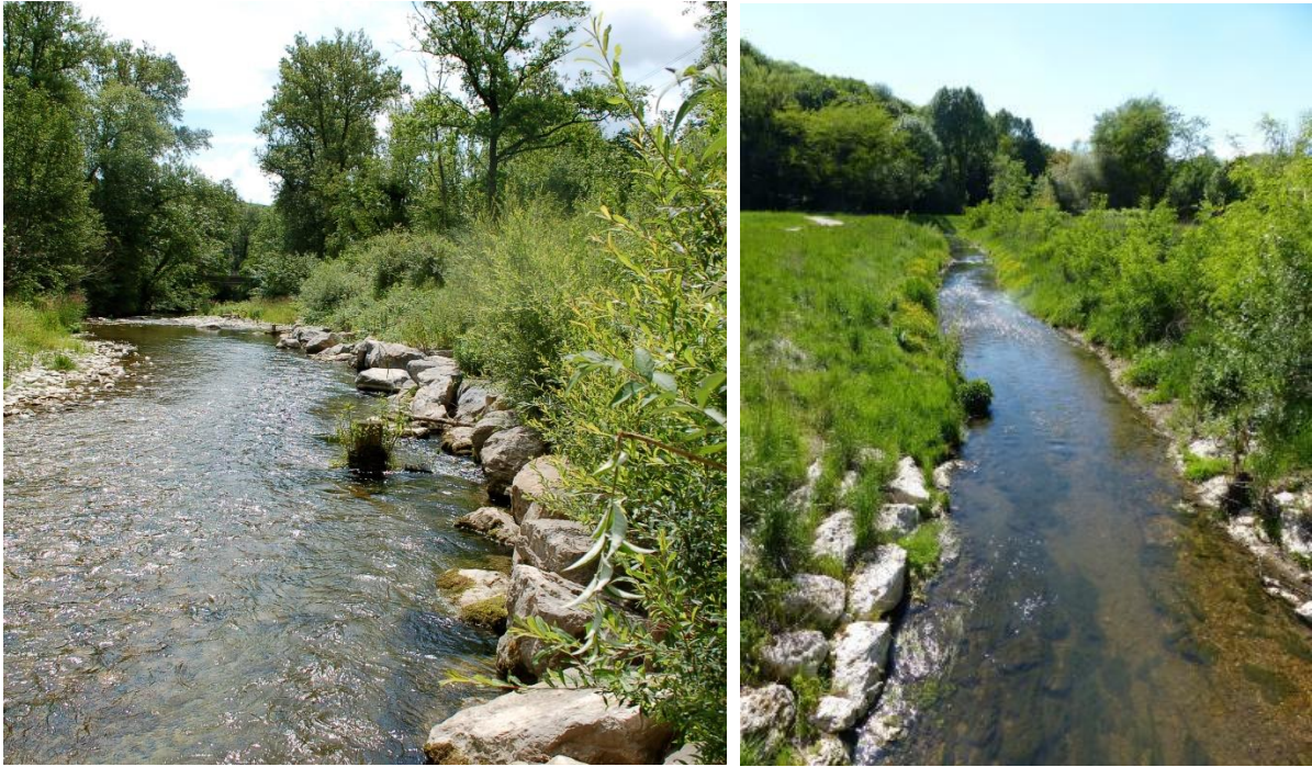
-Exemples de stabilisation de berges à l'aide d'enrochement –
